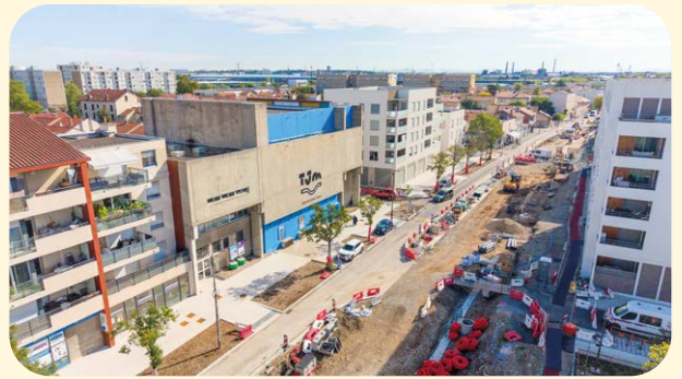
Devant le théâtre Jean Marais à Saint-Fons, les travaux de terrassement et d'aménagement sont en cours sur la rue Carnot.
