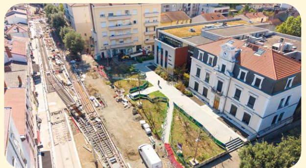
Devant la mairie de Saint-Fons, les rails ont été posés et les travaux d'aménagement se poursuivent au sud de la rue Charles Plasse.
