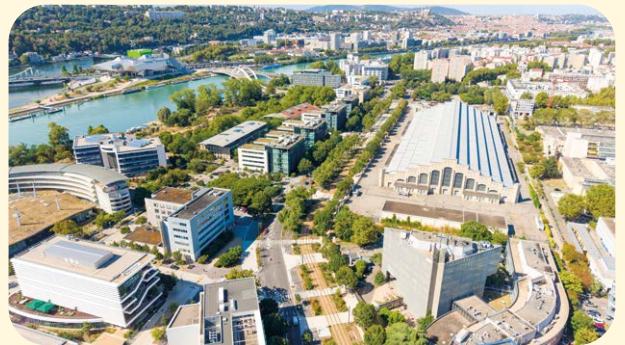
Depuis la Halle Tony Garnier, la plateforme du T10 est désormais achevée sur l'ensemble du secteur de Lyon 7 e .
