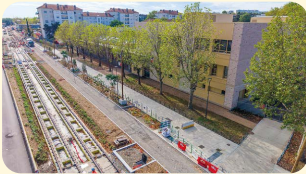
Les rails sont posés sur l'avenue de la République devant le collège Katia Krafft à Vénissieux.
