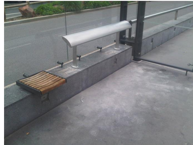
Mise en place d'appuis ischiatiques « assis-debout » dans les stations tramway
