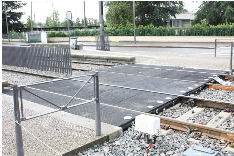
Bande d'Eveil à la Vigilance pour 17 traversées piétonnes de la ligne de tramway T3
