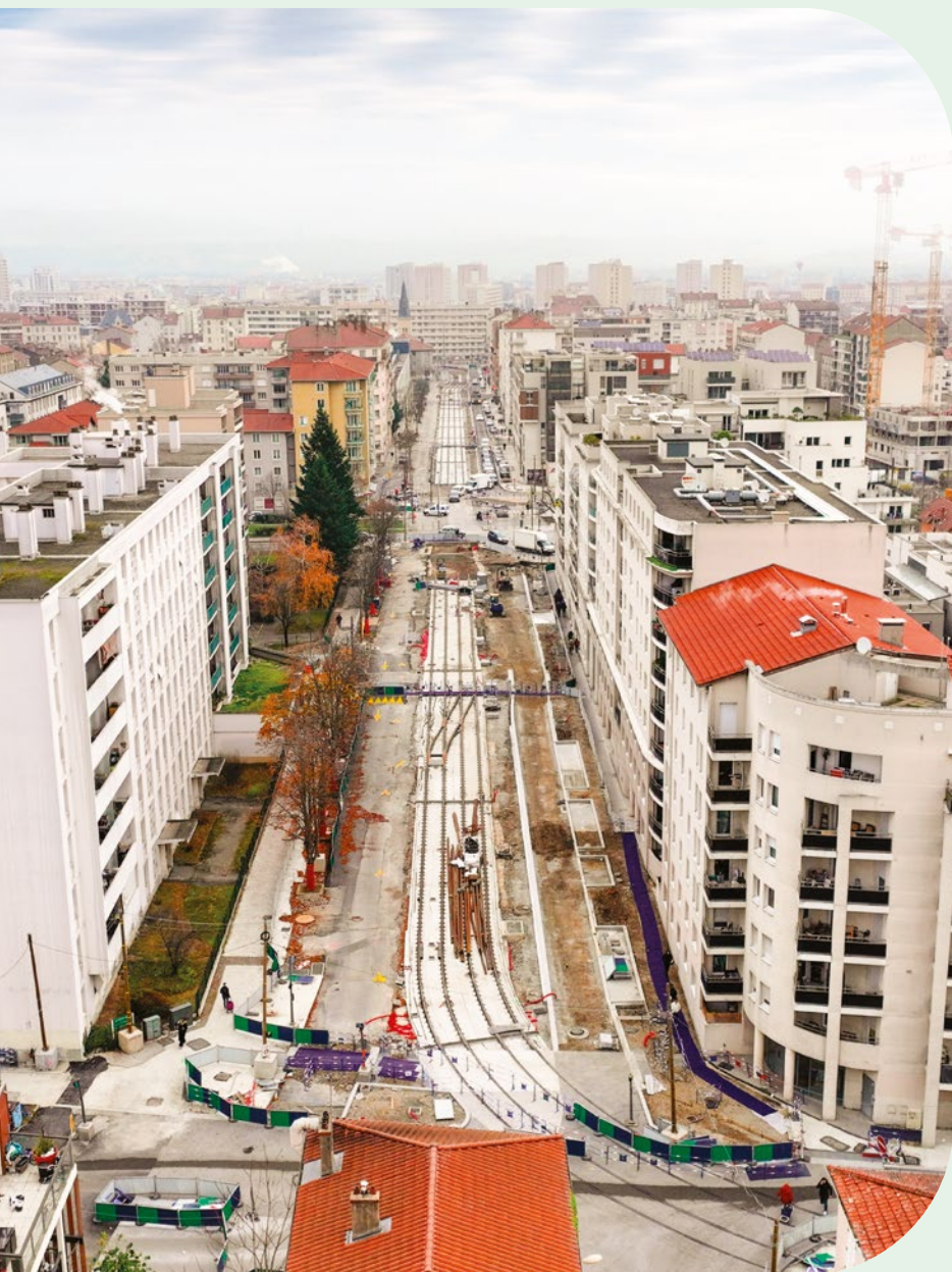
Pose des voies avenue Général Leclerc (décembre 2024)
