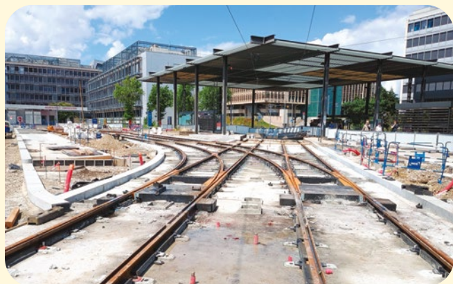
La Doua : pose des appareils de voies
