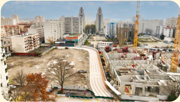
Vues du ciel, la plateforme du tramway est achevée et la ZAC Gratte Ciel en construction
