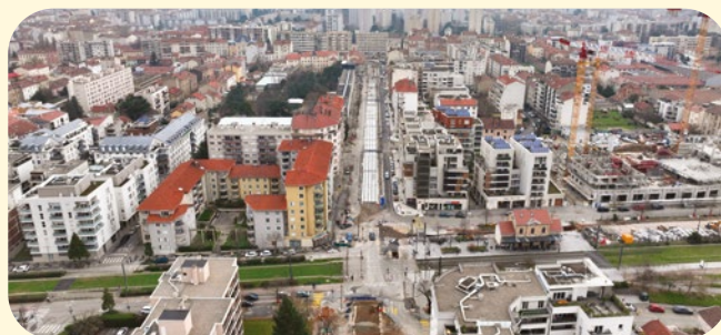
Connexion de la ligne T6 avec la ligne T3, au niveau de la Gare de Villeurbanne
