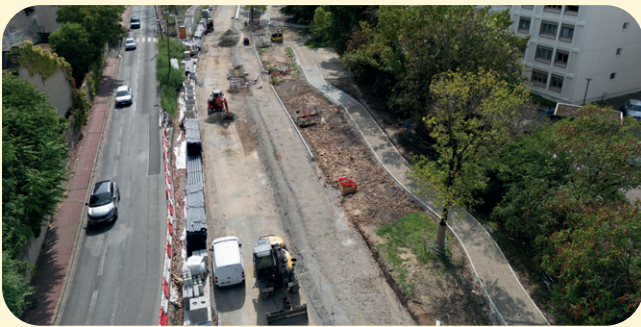
Travaux en cours au niveau du square Gérin
