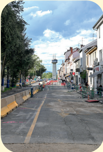
La rue Charles Plasse se prépare à accueillir la future plateforme.
