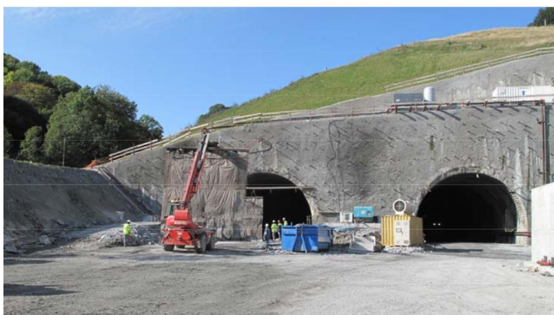
Figure 9 : Tête de tunnel en paroi clouée (tunnel bitube du Violay)
