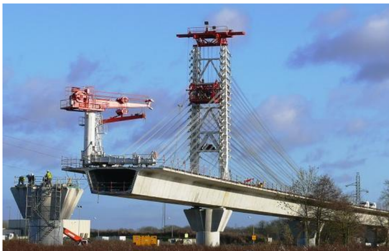
Figure 7 : Réalisation d'un viaduc à voussoirs préfabriqués par encorbellement avec haubanage provisoire – viaduc de Compiègne
