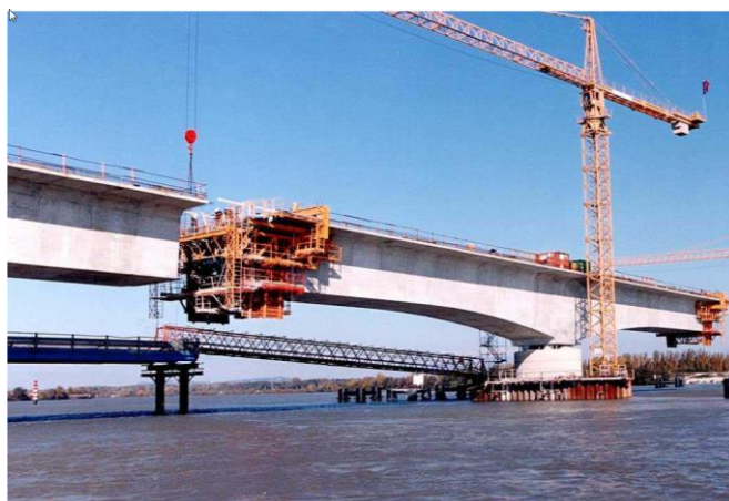
Figure 6 : Exemple d'équipage mobile pour voussoirs coulés en place
