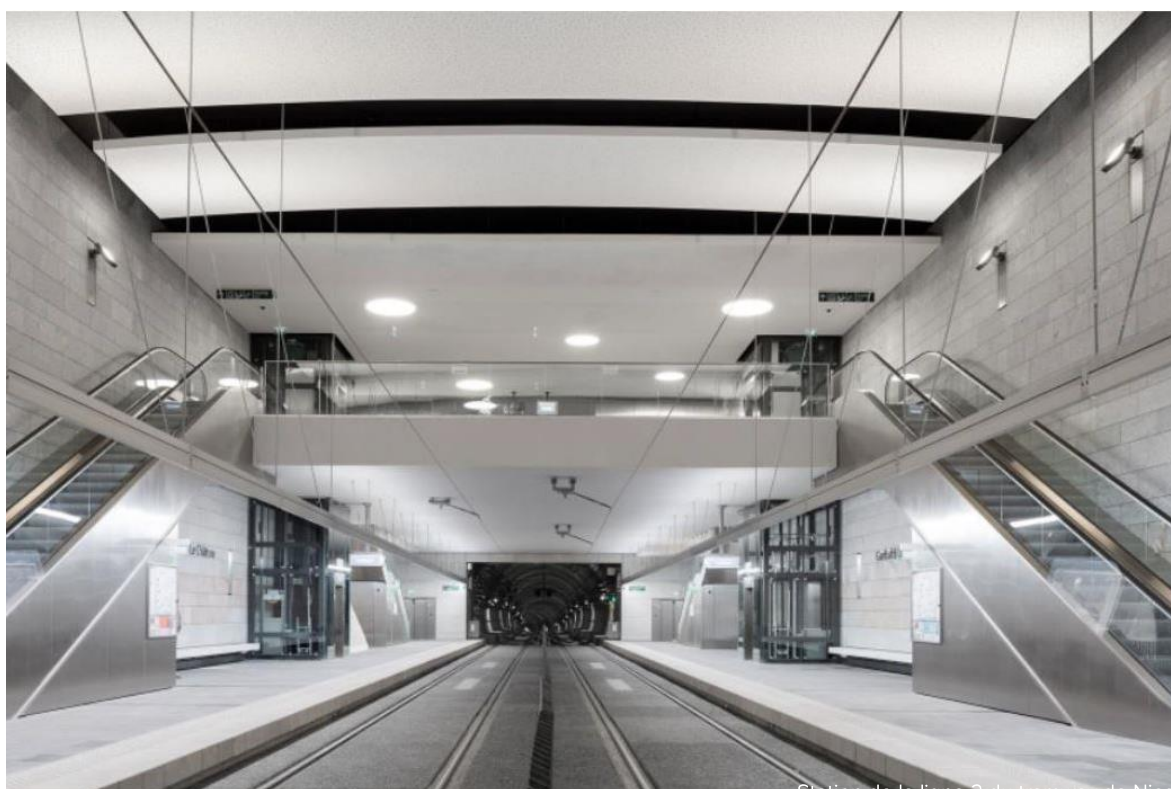
Station de la ligne 2 du tramway de Nice
